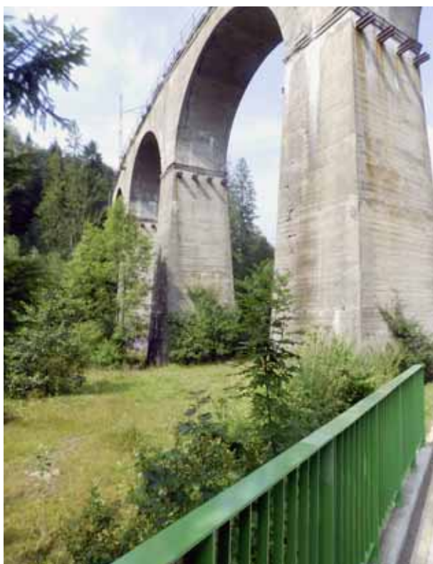
Wisła Głębcze, wiadukt kolejowy
