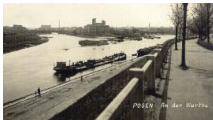
Ryc. 7. Połączenie kanału ulgowego z korytem głównym podczas powodzi (prawdopodobnie) w 1941 roku [w zbiorach autora; 1941, b.w.; o.p., dat. kor.: 1.10.41]
