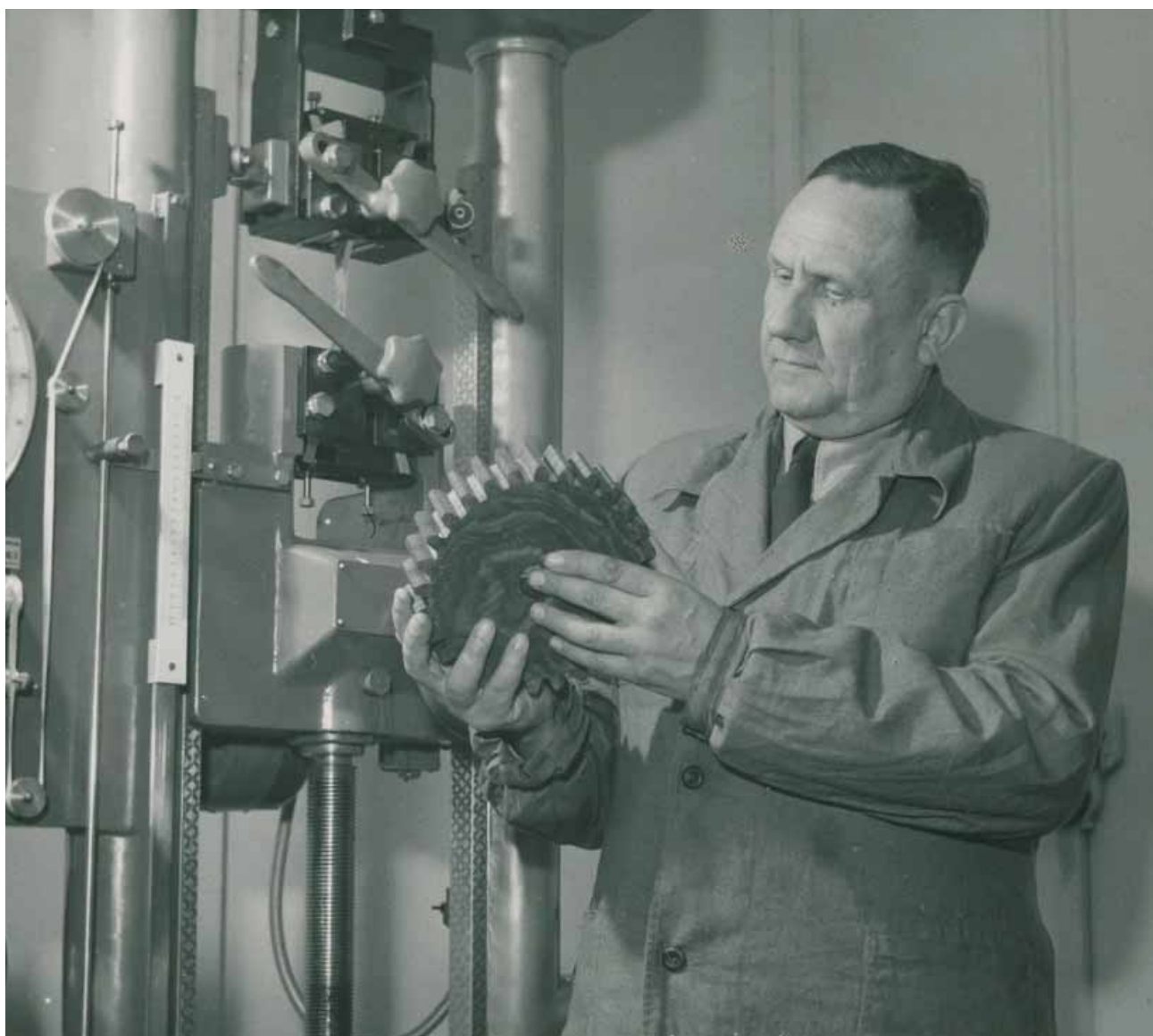
Tadeusz Perkitny przy maszynie wytrzymałościowej z kołem zębatym wykonanym z lignofolu skrawkowego
