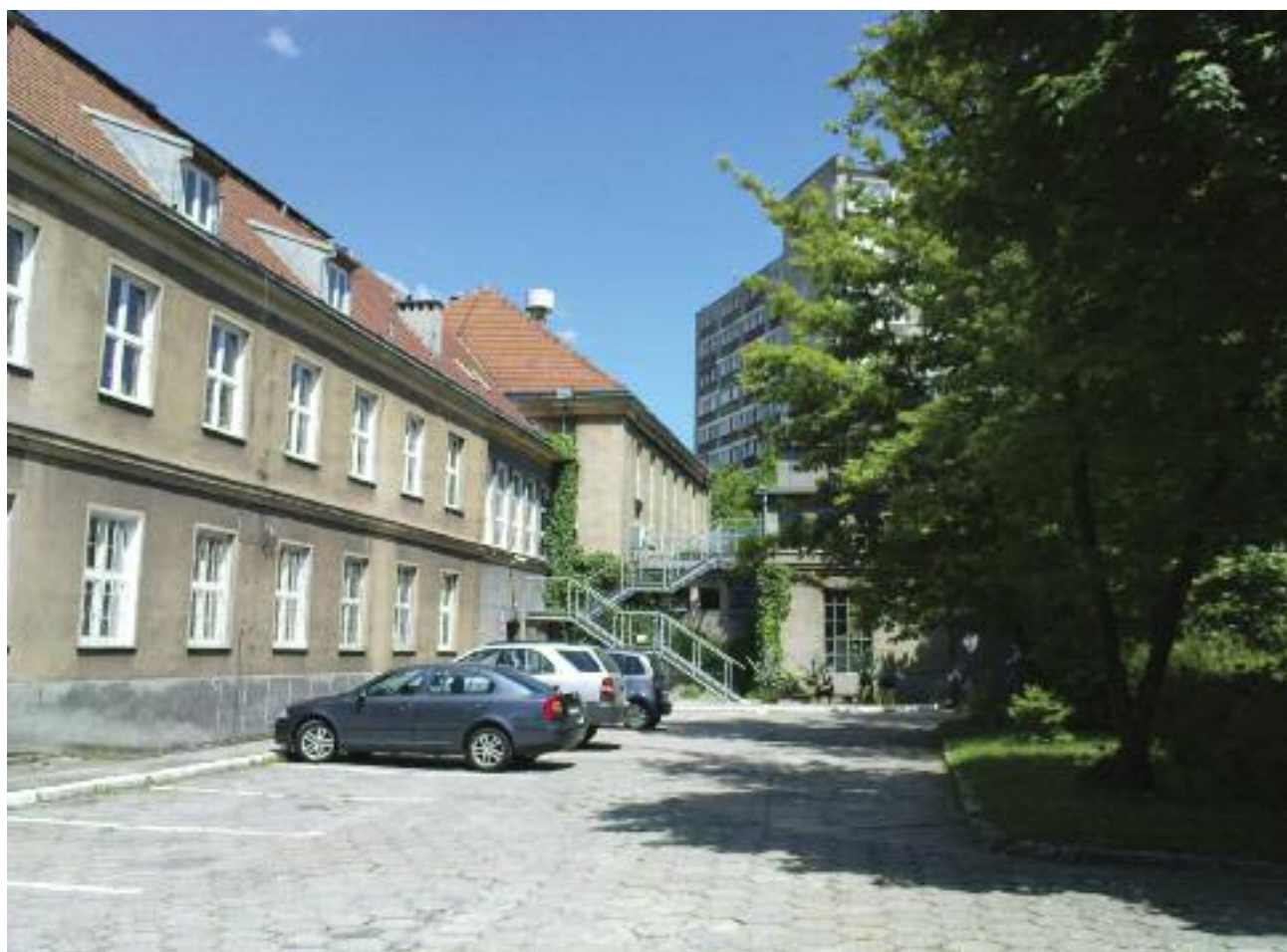
Widok budynku głównego Instytutu Mechanizacji Rolnictwa
