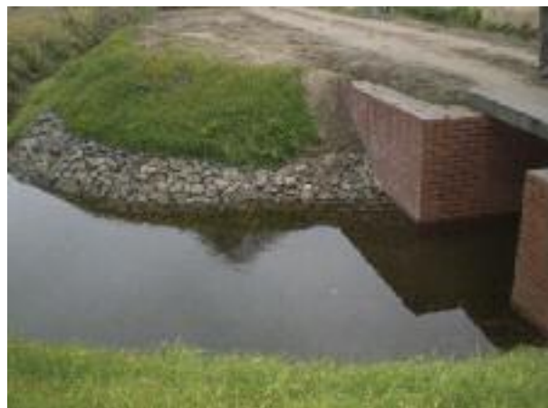
Przepust melioracyjny umocniony gabionami
