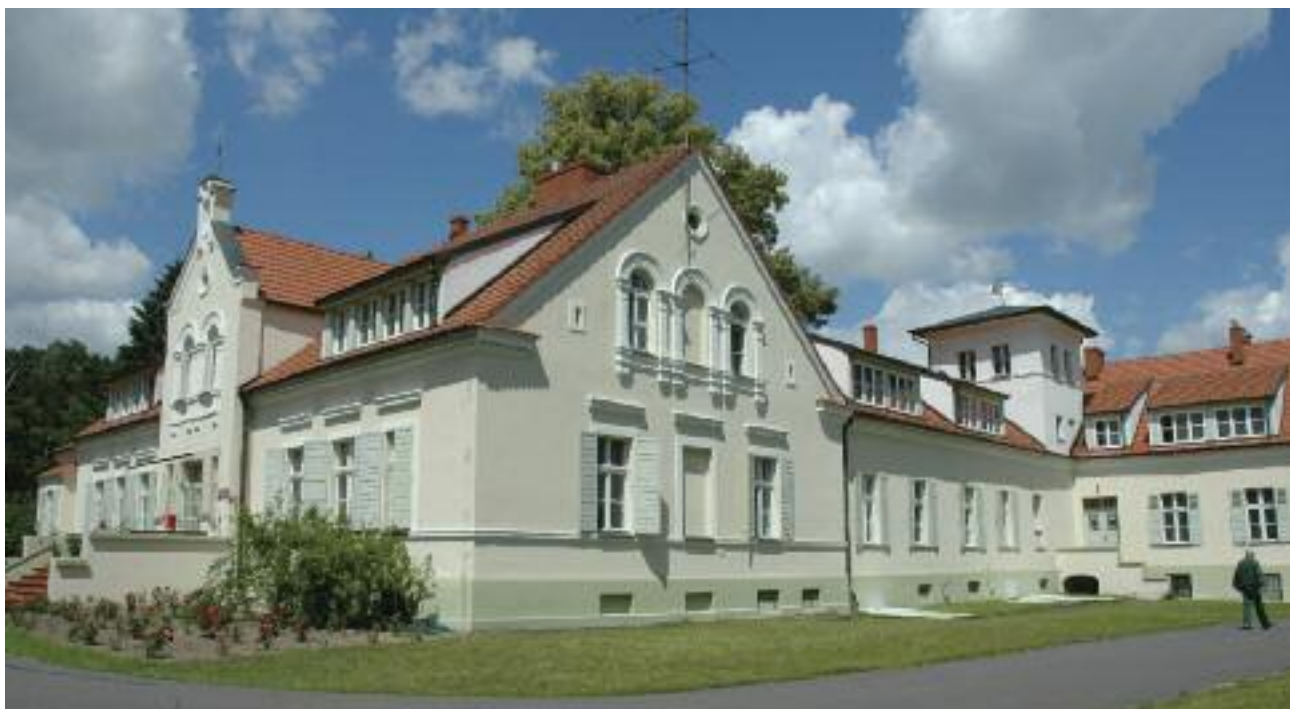
Dom Pracy Twórczej w Ustroniu, w którym mieści się również terenowa Stacja Urządzenia Lasu
