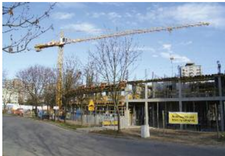
W trakcie budowy (jesień 2013 roku)
