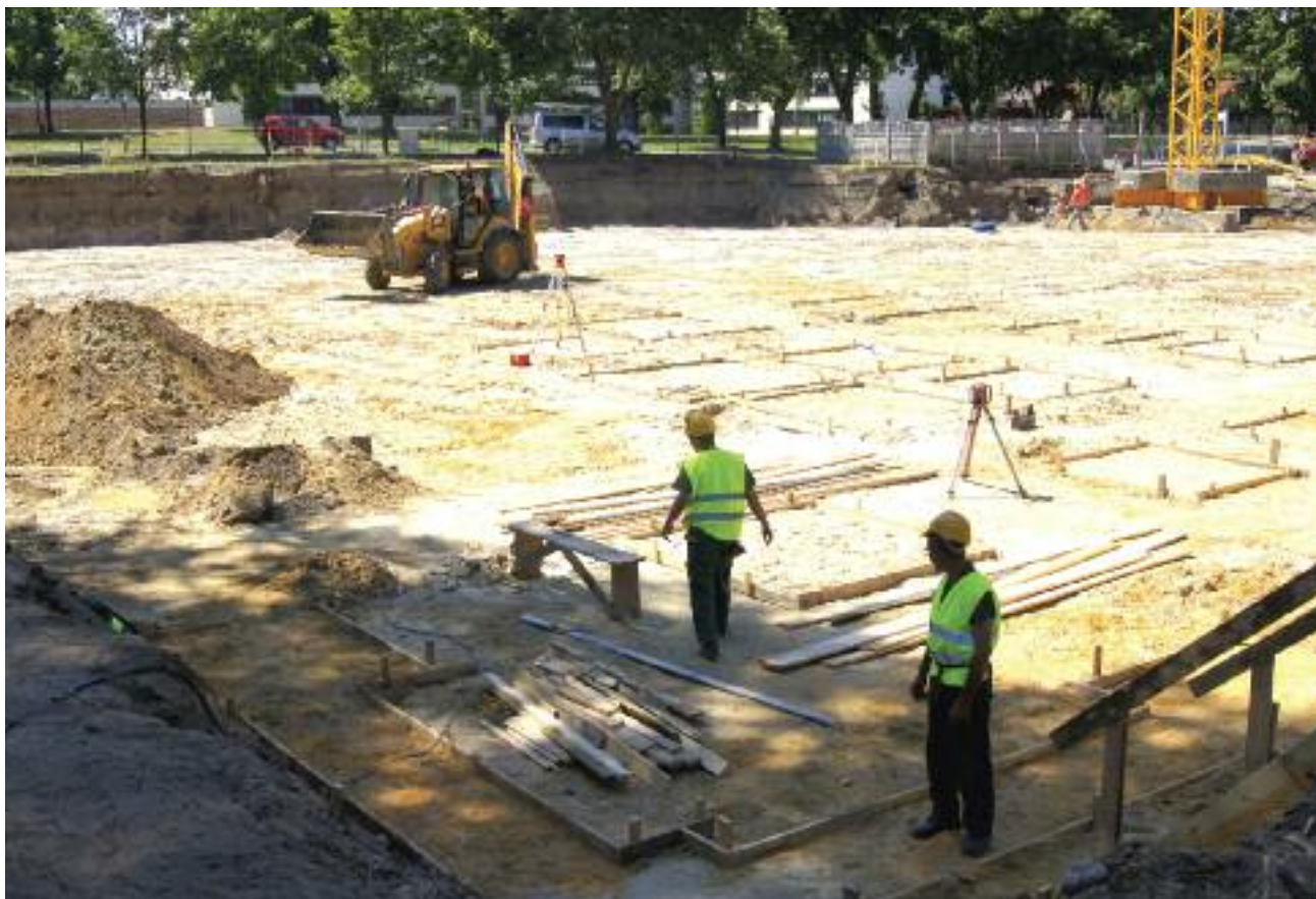
Początek budowy Kliniki Dużych i Małych Zwierząt (lipiec 2013 roku)
