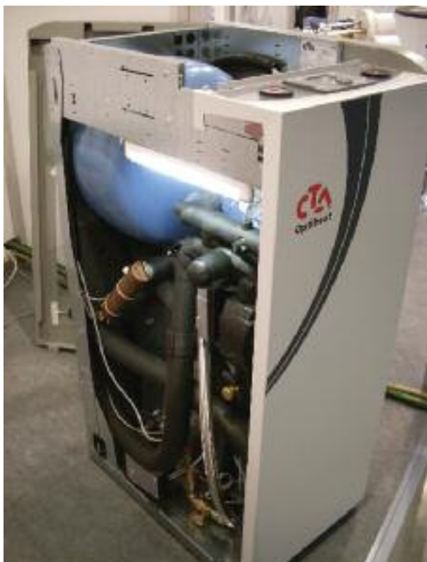
Pompa ciepła od środka
