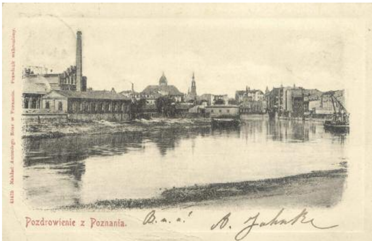
Ryc. 3. Kaponiera Warciańska na wejściowym odcinku Zakola Chwaliszewskiego (ok. 1900 r.)
