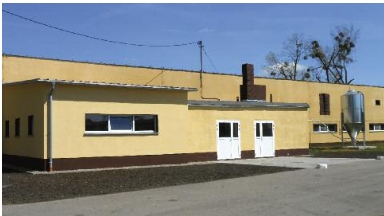
Dobudowana hala udojowa
