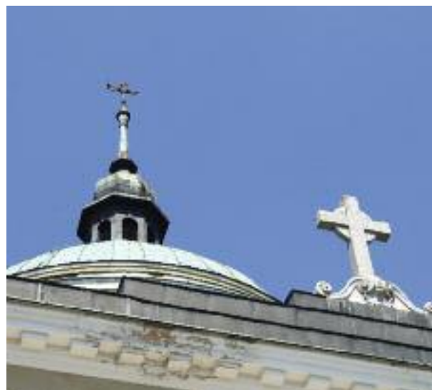
Zwieńczona krzyżem latarnia nad kopułą sołackiej świątyni
