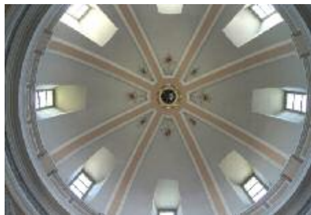
Sklepienie kopuły w nawie głównej
