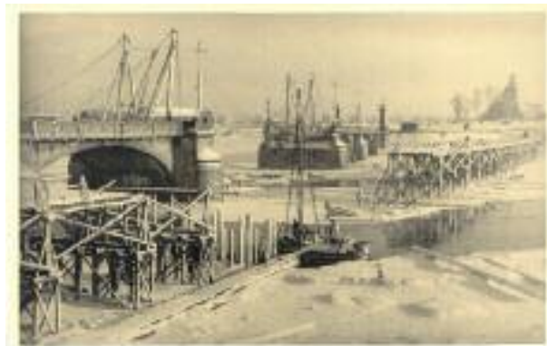
Ryc. 5. Wyszadzone przęsło nurtowe mostu św. Rocha i budowa saperskiego mostu Major Schweizer Brücke (w 1940 roku) [w zbiorach autora; b. wyd.; b.o.p., dat. kor.:14.02.40]
