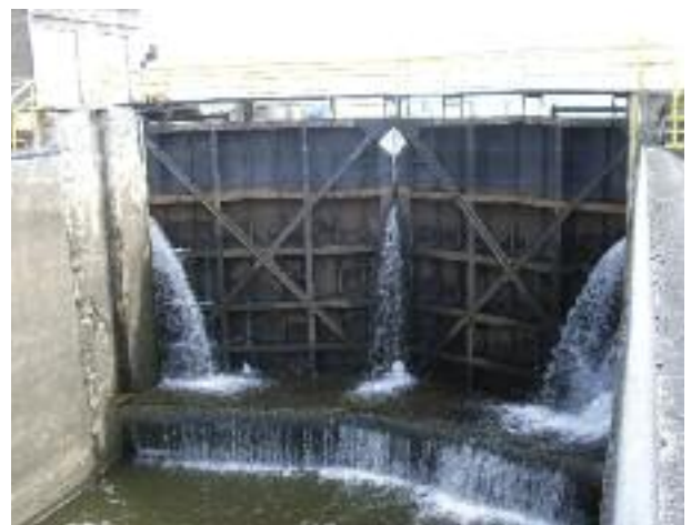
Zamknięcie śluzy (Brzeg Dolny)
