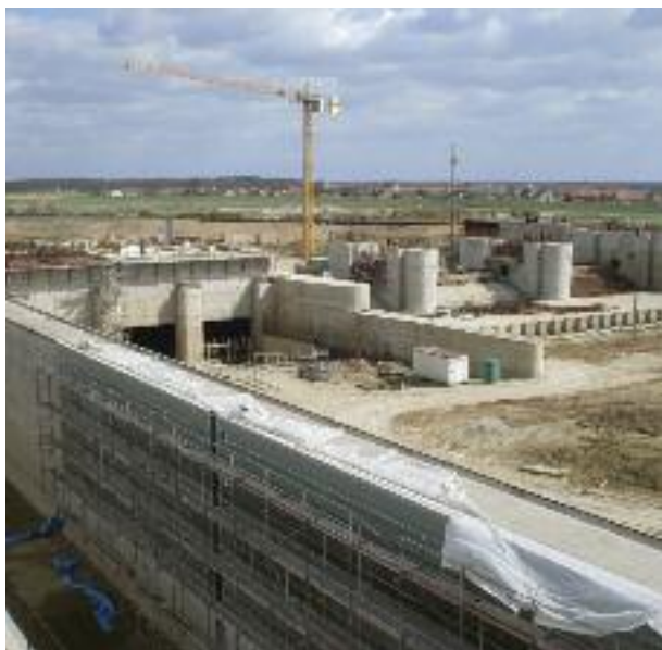
Widok na plac budowy Stopnia Wodnego Malczyce ze sterowni
