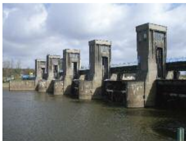
Jaz piętrzący wody Odry na Stopniu Brzeg Dolny
