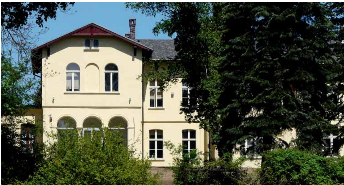
Dworek Sołacki; widok od strony Ogrodu Dendrologicznego
