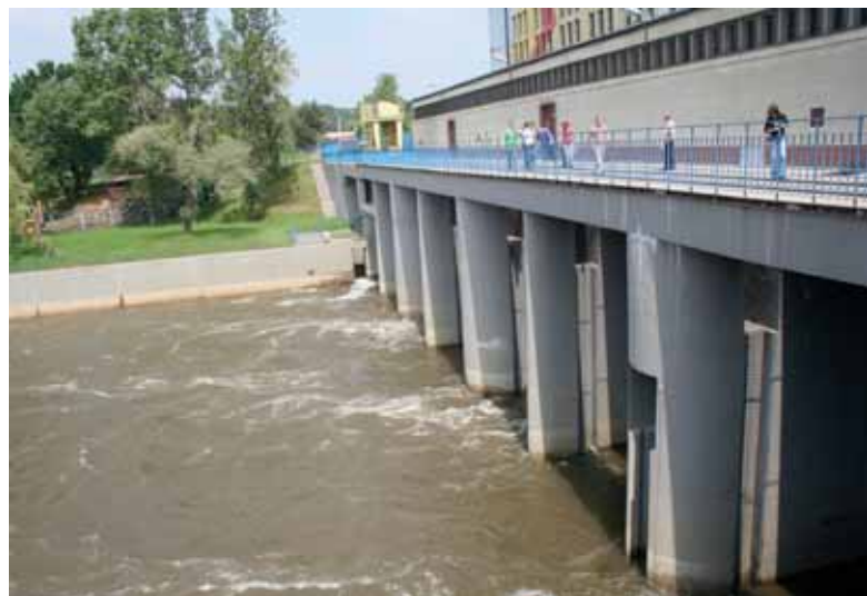
Elektrownia wodna na rzece Odrze
