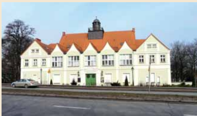
Kolegium Rungego przy ul. Wojska Polskiego 52 – XIX-wieczny budynek, który po renowacji otrzymał Nagrodę Ministra Kultury i Sztuki za „Najlepiej odrestaurowany obiekt zabytkowy w Polsce w roku 1995”
