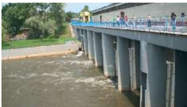
Elektrownia wodna na rzece Odrze
