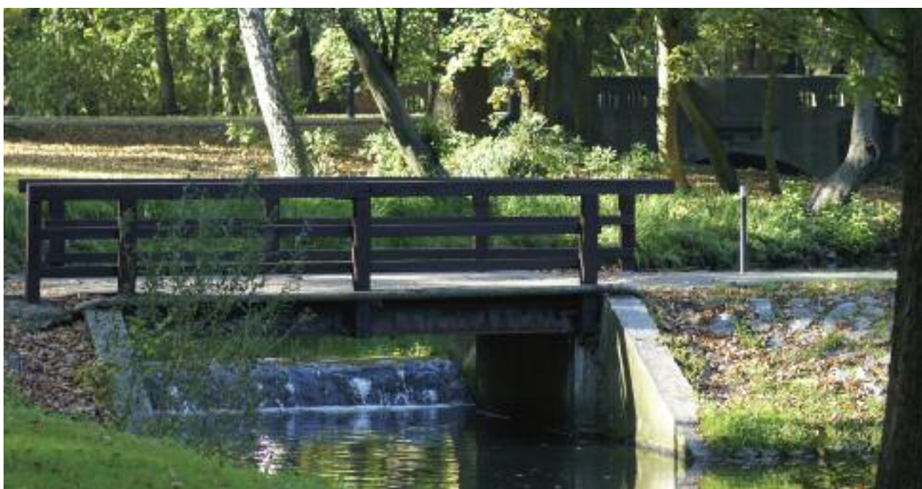
Kolejny sołacki mostek
