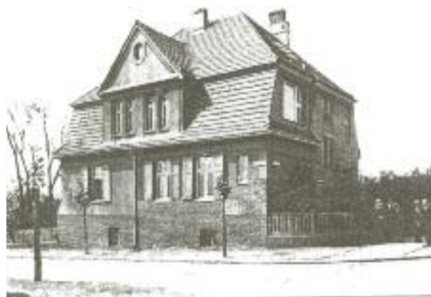
Budynek przy ul. Mazowieckiej
