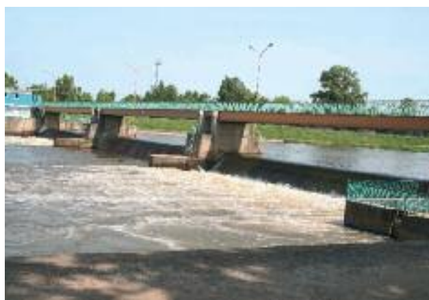
Piętrzenie wody z wykorzystaniem jazu
