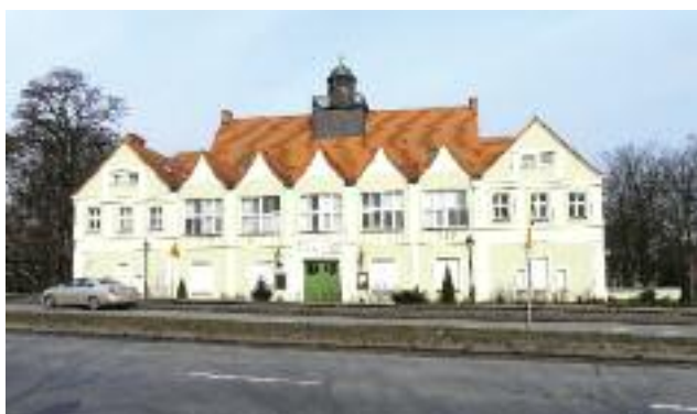
Kolegium Rungego przy ul. Wojska Polskiego 52 – XIX-wieczny budynek, który po renowacji otrzymał Nagrodę Ministra Kultury i Sztuki za „Najlepiej odrestaurowany obiekt zabytkowy w Polsce w roku 1995”
