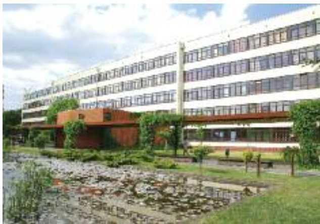
Collegium Technologiae Ligni – czyli budynek Wydziału Technologii Drewna
