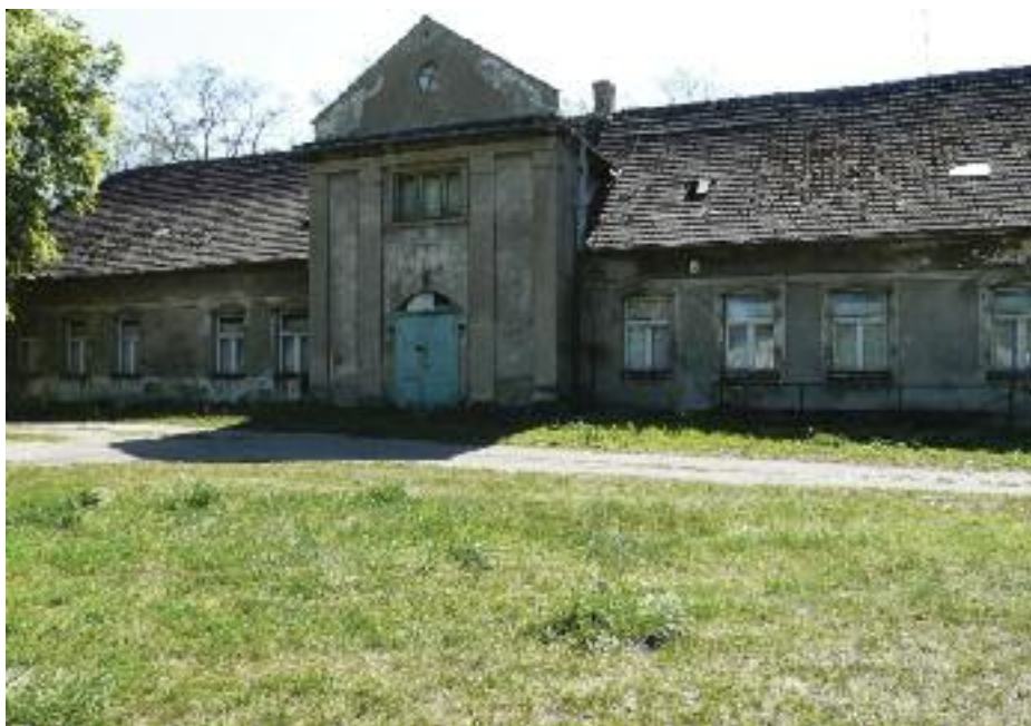
Remontowany od roku dwór Cieszkowskich w podpoznańskiej Wierzenicy
