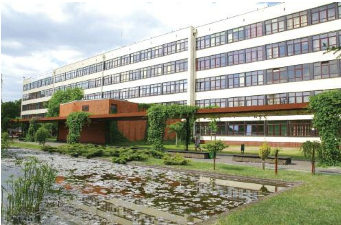
Collegium Technologiae Ligni – czyli budynek Wydziału Technologii Drewna
