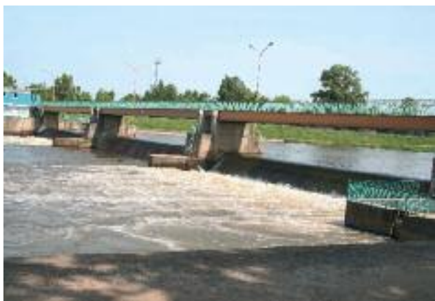
Piętrzenie wody z wykorzystaniem jazu
