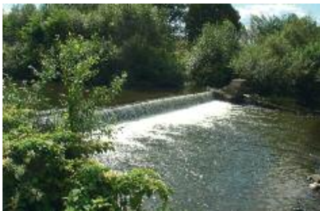
Próg piętrzący wodę
