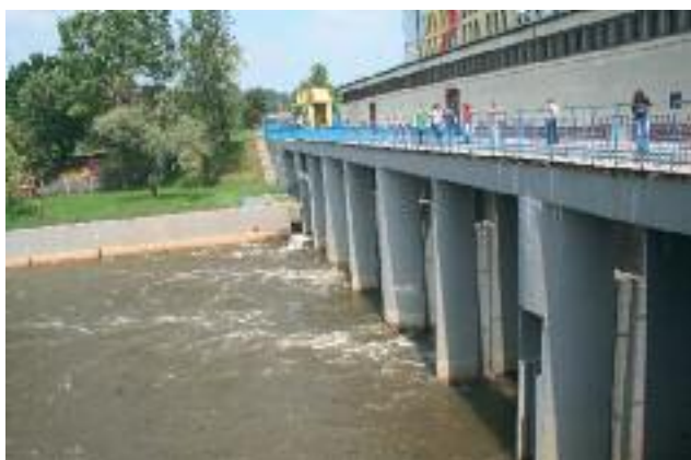
Elektrownia wodna na rzece Odrze
