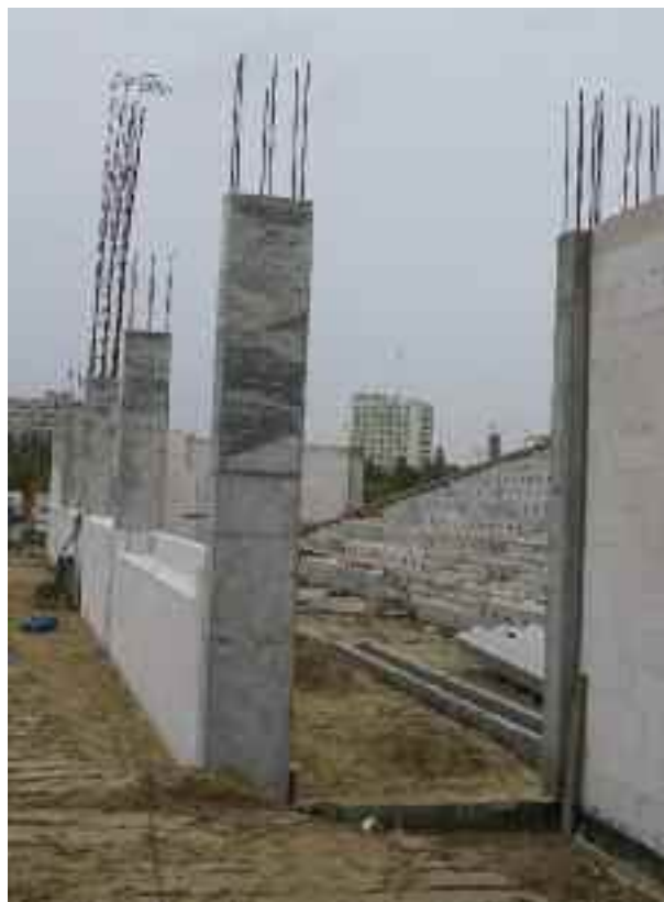
Widok budowy dziś
