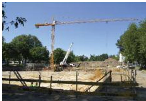
Początek budowy Kliniki Małych i Dużych Zwierząt (lipiec 2013 roku)
