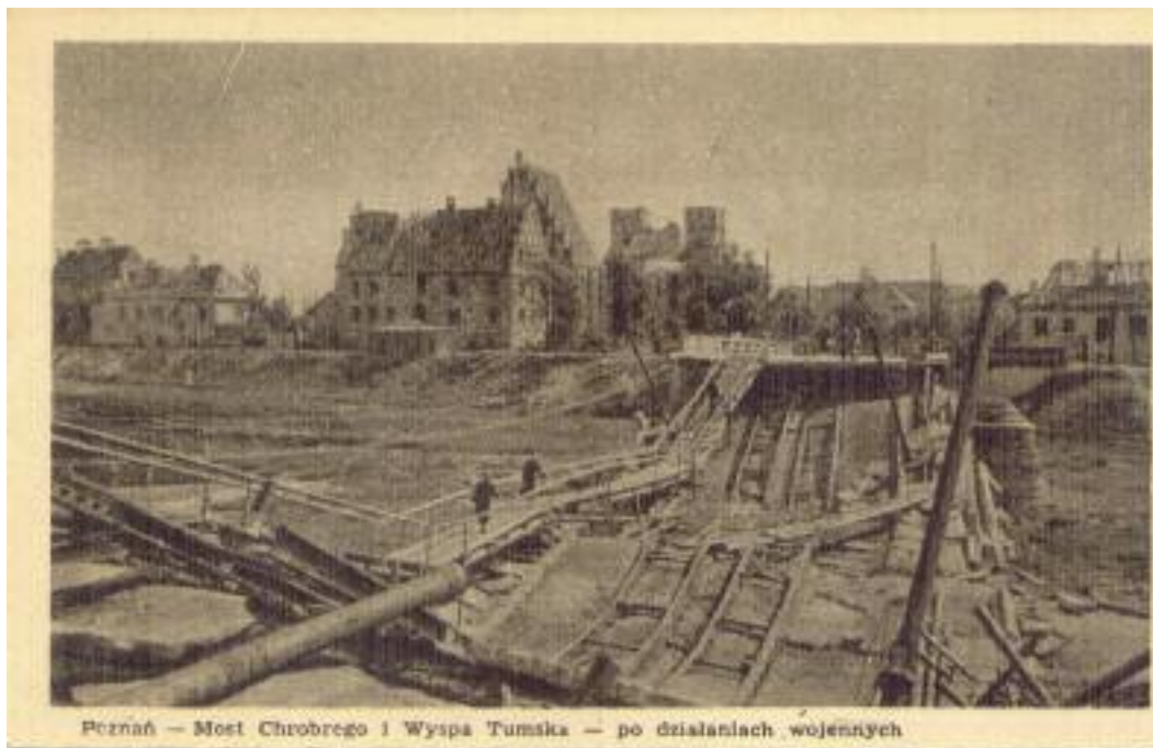
Ryc. 1. Zniszczony most Chrobrego (1945), przejście umożliwiła prowizoryczna kładka
