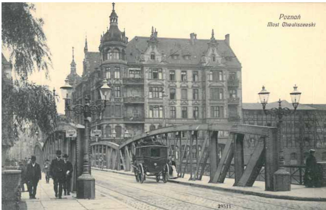
Ryc. 2. Most Chwaliszewski z poziomu jezdni na Chwaliszewie z widokiem w kierunku ul. Wielkiej. Doskonale przedstawia konstrukcję mostu, jego pasy górne, zmienne słupki i krzyżulce (także z przewiązkami) oraz doskonale oddaje połączenia nitowane – można odwzorować układ nitów a łączniki te policzyć. Jednocześnie to pocztówkowy dowód ruchu prawostronnego na moście – tabliczki z napisem „Rechts” i dłonią wskazującą miejsce przejazdu/przejścia.
