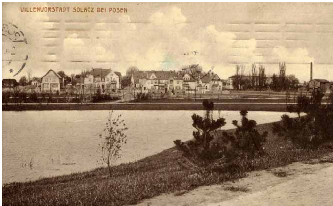
Ryc. 1. Widok na północ przez duży staw na zabudowę Sołacza w obrębie pl. Spiskiego i ul. Podolskiej (około 1910 roku)
