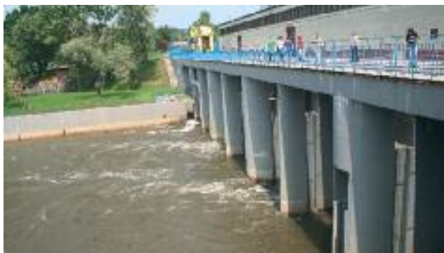
Elektrownia wodna na rzece Odrze
