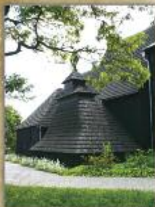
Zadaszenie krypty Cieszkowskich przylegające do północnej strony nawy
