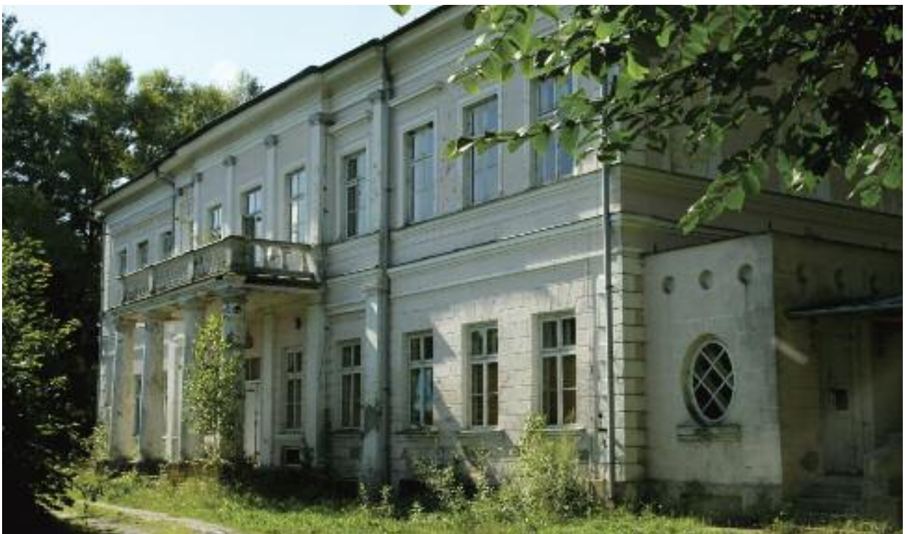
Pałac w Orłowie Murowanym (stan z 2011 roku)
